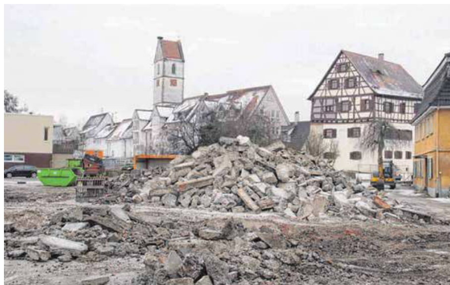
Die Abrissarbeiten haben begonnen: Von der Alten Straße kann man jetzt bis zur Martinskirche hinüberschauen.
